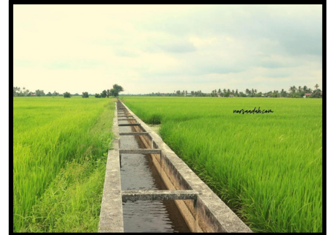
Membina empangan dan tali air untuk tanah pertanian
